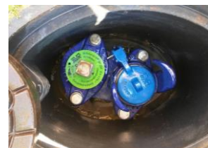
selbstschließender Gussdeckel
